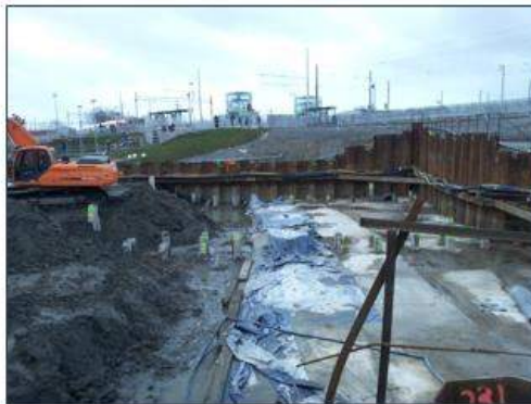
Figur 17. Förfarande för etappvis schakt, läge för foto visas öster om sponten.
