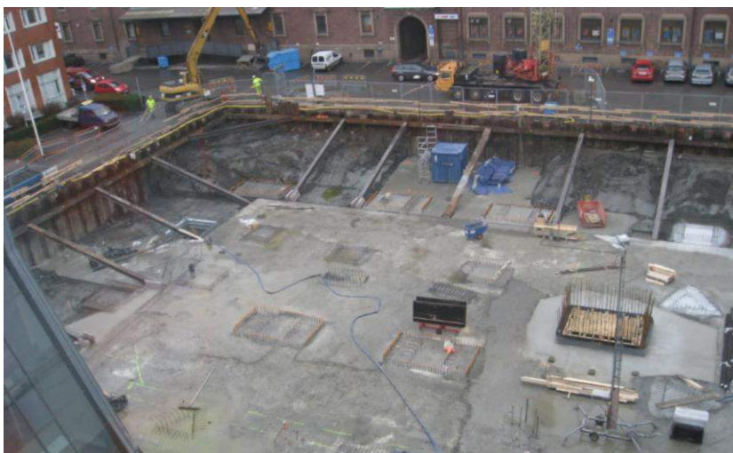
Figur 31. Utförande av etappvis schakt. Kämpegatan ovan/till höger i bild. Foto taget 2011-11-18 från befintlig kontorsbyggnad Tennet 1.
