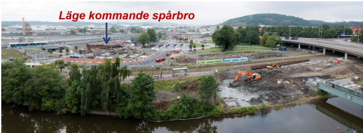
Figur 15. Del av arbetsområdet, foto mot norr med Säveån i förgrunden. Del av spont för spårbron installerad och inledande arkeologischakter pågår öster om befintlig spårvägsbank samt järnvägsbro.
